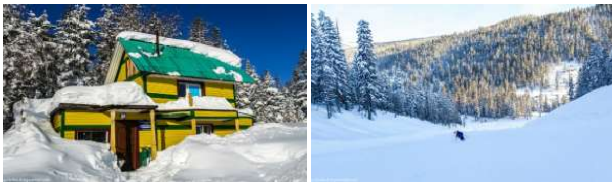
Рис. 1. Состояние базы в 2015 году
