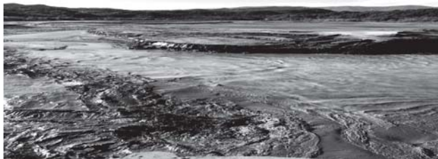
Рис. 1. Зона заиления водохранилища Гумати ГЭС
