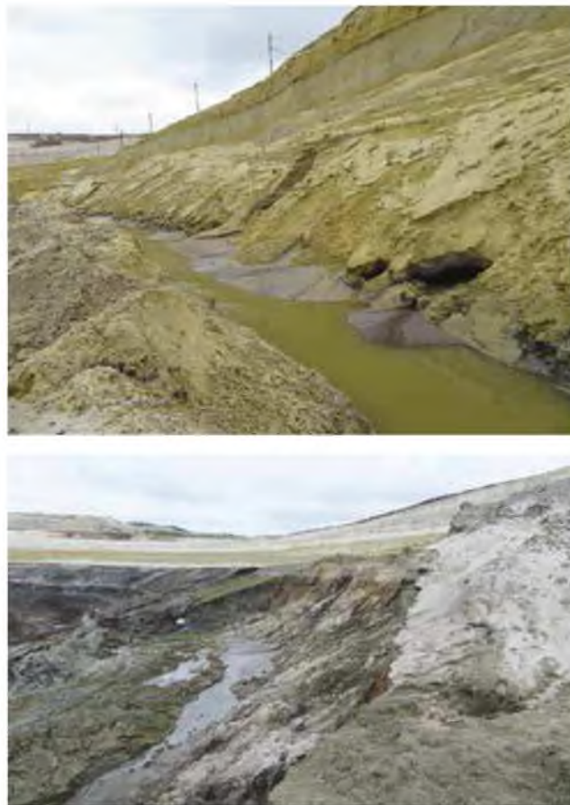
Рис. 1. Проявление суффозионных выносов и оплывин на гор. +93 м
