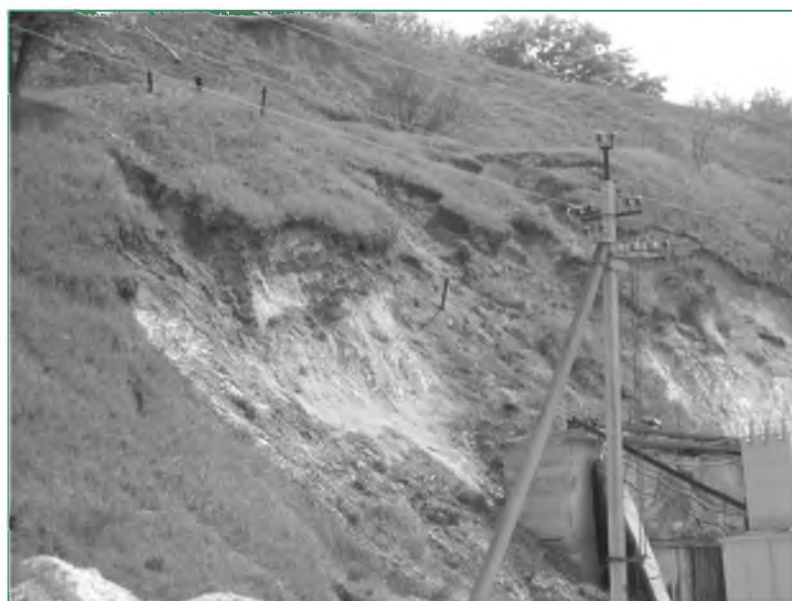
Рис. 2. Оползень в районе авторынка
