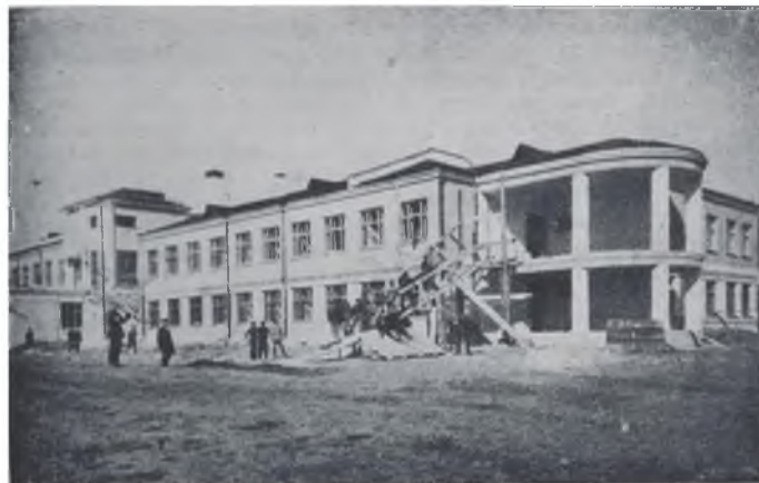
Рис. 4. Хирургический корпус больницы в Троицке. Источник: [Белостоцкий] Fig. 4. Surgical building of hospital in Troitsk
