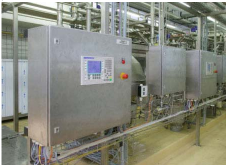
Рис. 3.4. Шкафы ввода/вывода с вмонтированными операторскими панелями
