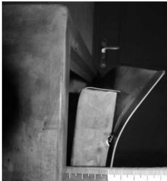
Фото 2. Вид деформированной части дверцы сейфа.
