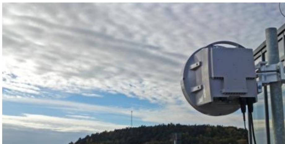
Рисунок 5.7 – Внешний вид блоков RRU и AIR.
