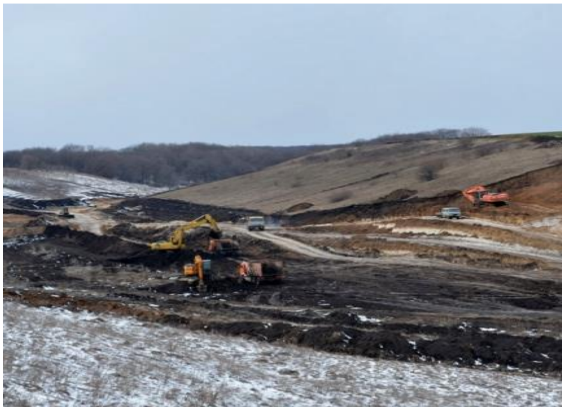
Рис. 3.19. Полигон ТБО в Губкине [37]
